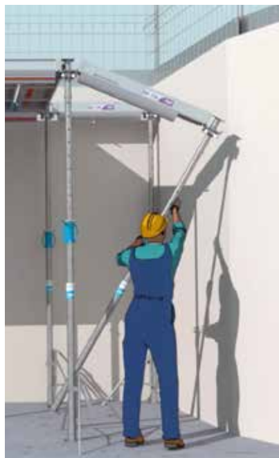
Die ausziehbaren Träger ermöglichen eine bessere Anpassung an die Randbereiche des Abschnitts
