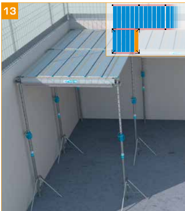
- Mit der Installation der Paneele Eco+ fortfahren.
