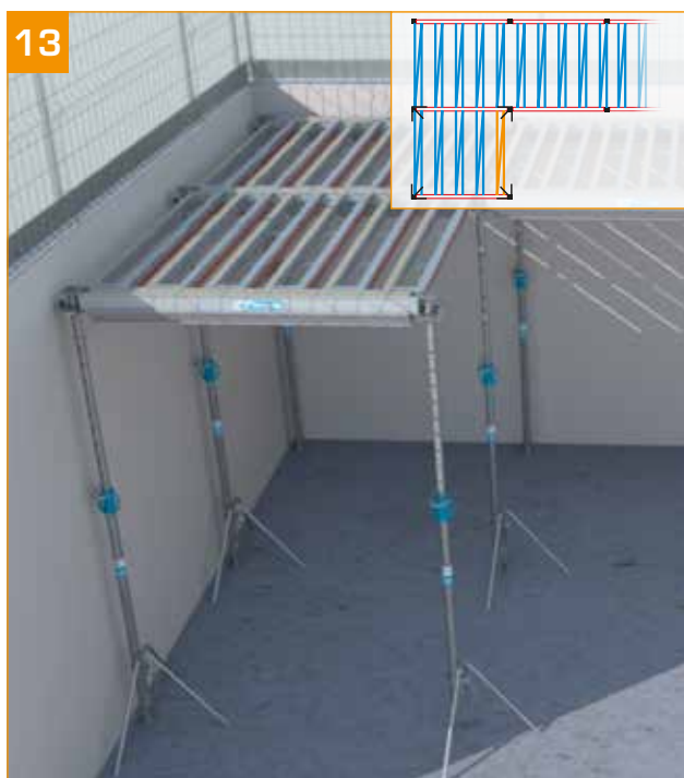
- Retomar a montagem das armações secundárias C2+ ou C4+.
